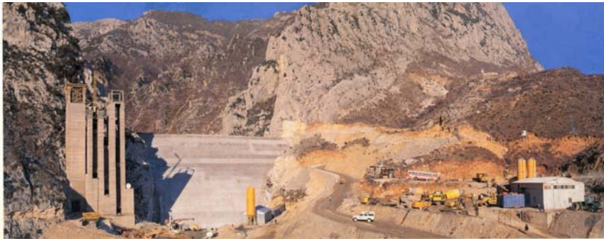
Figure 1-3. View of the working process of the hydrotechnical area. / Pamje e zonës hidroteknike gjatë fazës së punimeve (Anonymous, 1996).
